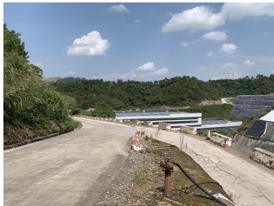
厂区道路（2021年9月）
