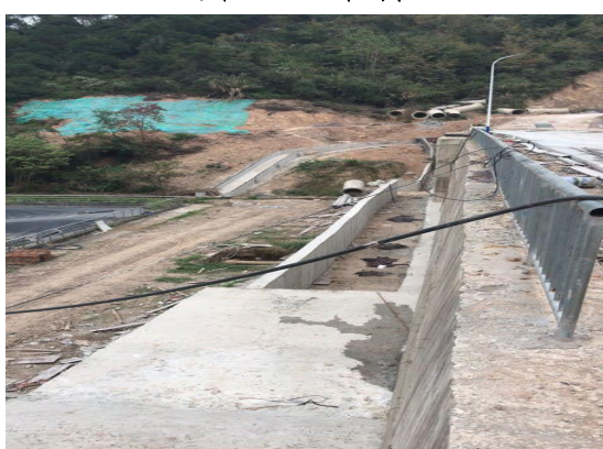
边坡防护（2020年8月）
