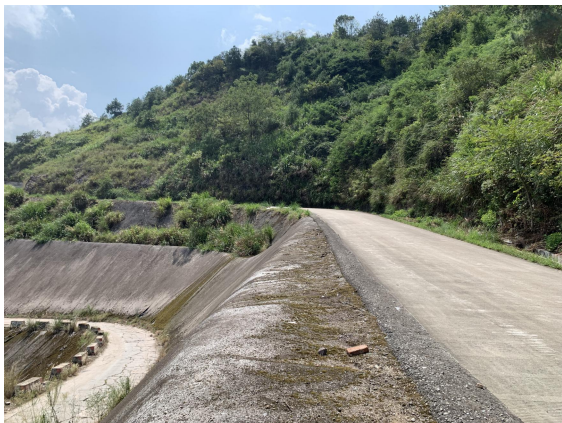
厂区道路（2021年9月）
