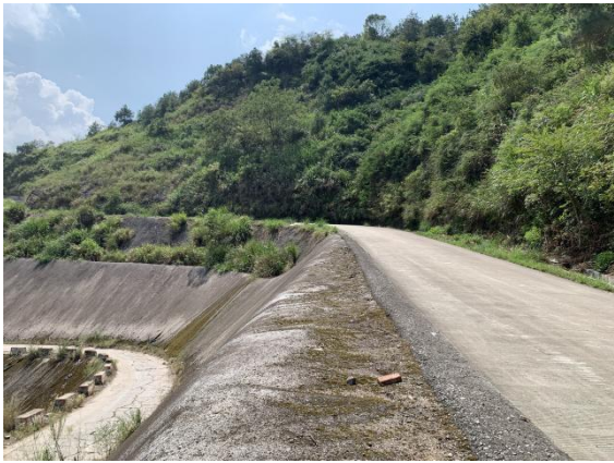
边坡防护（2021 年 9 月）
