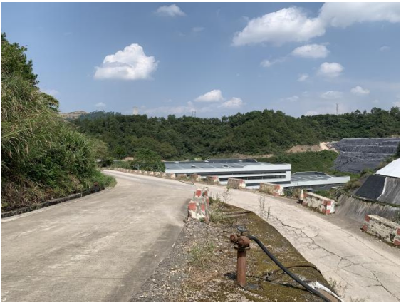
厂区道路（2021 年 9 月）
