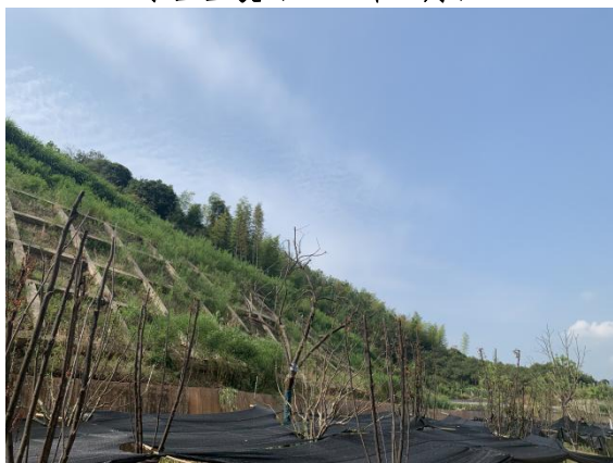
边坡防护（2021 年 8 月）
