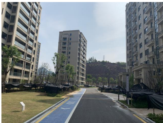
路面硬化（2021 年 8 月）
