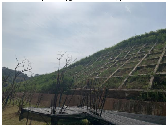
边坡防护（2021 年 8 月）
