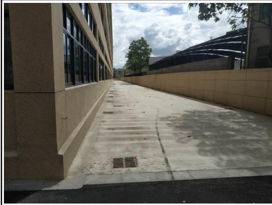
竣工现场照片
