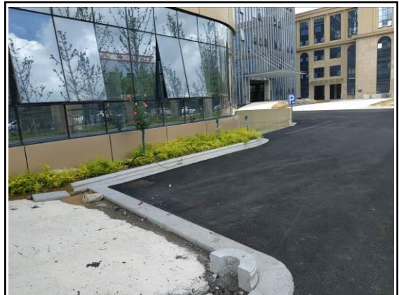
竣工现场照片
