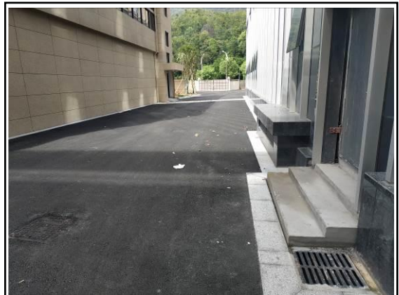
竣工现场照片
