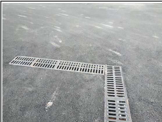
竣工现场照片
