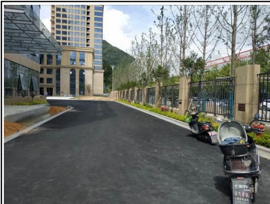
竣工现场照片
