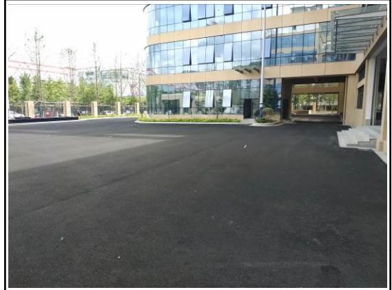
竣工现场照片
