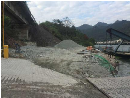
临时堆土区 (2019年2月)
