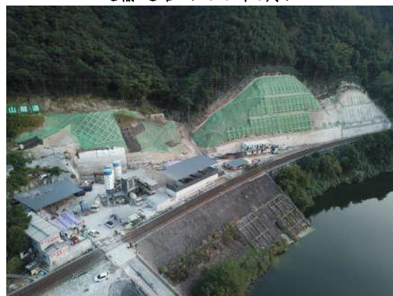
工程概况（2019年9月）
