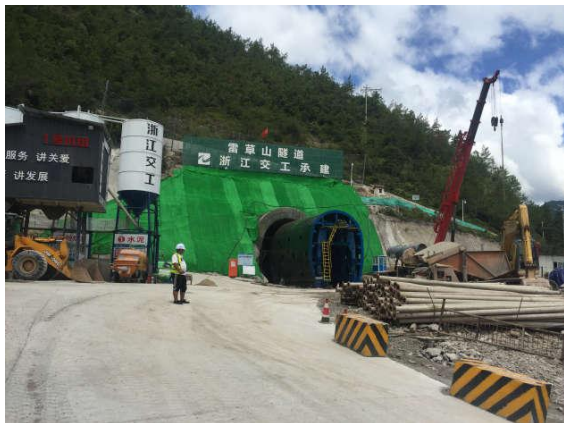
雷草山隧道 (2018年7月)
