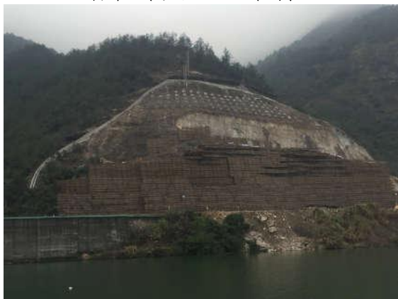
工程概况（2019年6月）
