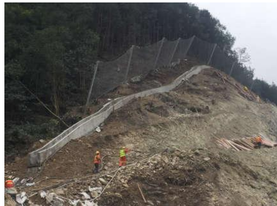
边坡排水沟（2019年6月）
