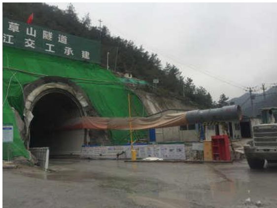
雷草山隧道（2019年6月）
