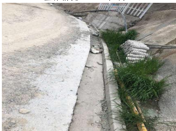
边坡排水沟 (2020年2月)
