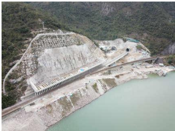
工程概况 (2020年2月)
