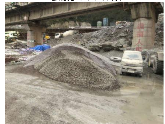
临时堆料区（2019年9月）
