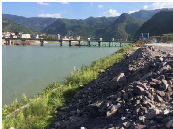
边坡状况 (2018年12月)
