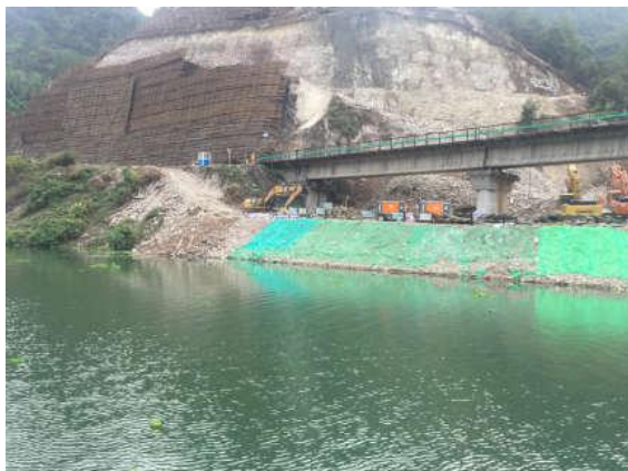
工程概况 (2019年2月)
