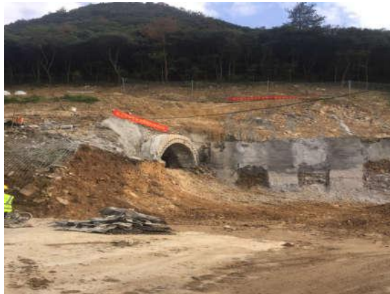
隧道开挖 (2018年12月)
