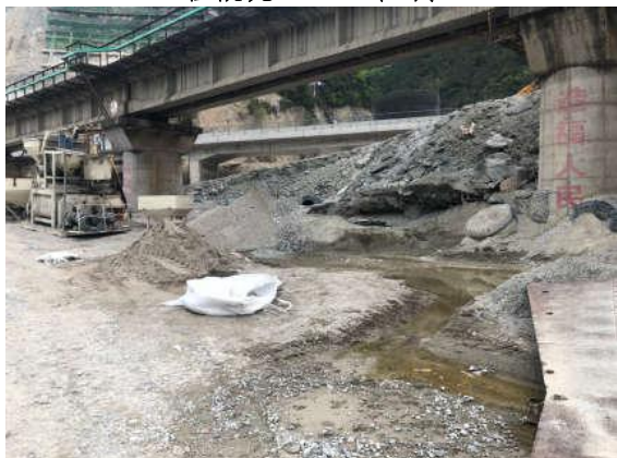
临时堆料区 (2020年2月)
