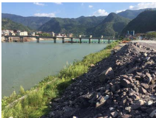
临时排水沟 (2018年12月)
