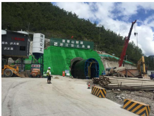
雷草山隧道 (2018年7月)
