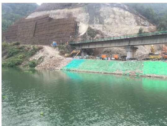
工程概况 (2019年2月)
