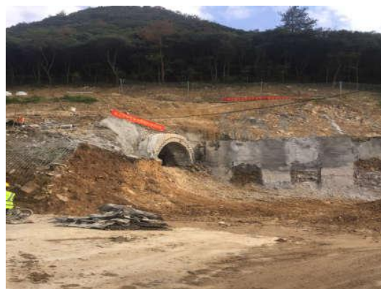
隧道开挖 (2018年12月)
