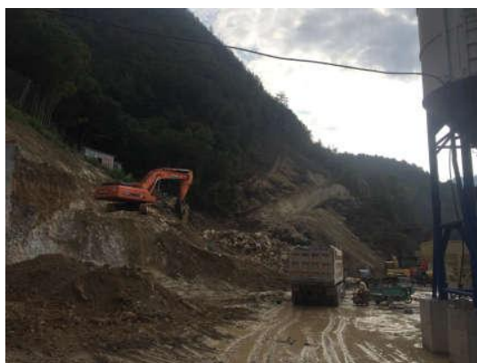
工程概况 2019年2月)
